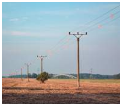
Ošetrený úsek vedenia, Adamovské jazerá.
