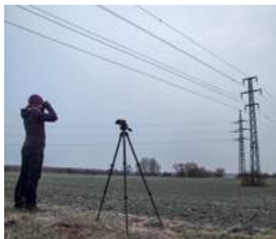
Monitoring ošetreného vedenia.
