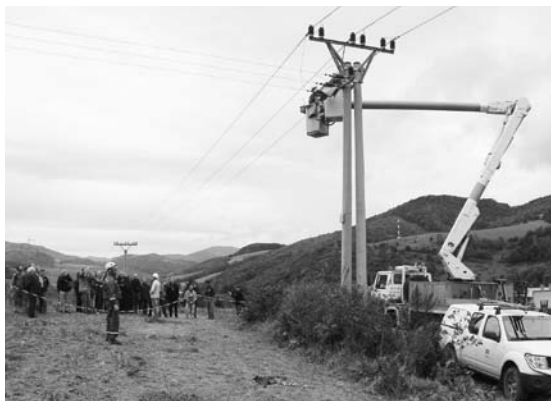
Demonštračná ukážka inštalácie konzolových chráničiek na stĺpy 22 kV elektrického vedenia Východoslovenskou energetikou Holding, a.s. Foto: B. Maderič
