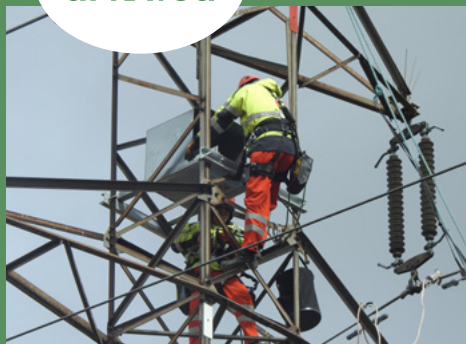
Obr. 2 Predtým - inštalácia búdky na stožiar 110 kV vyžadovala presnosť a najmä fyzickú zdatnosť.
