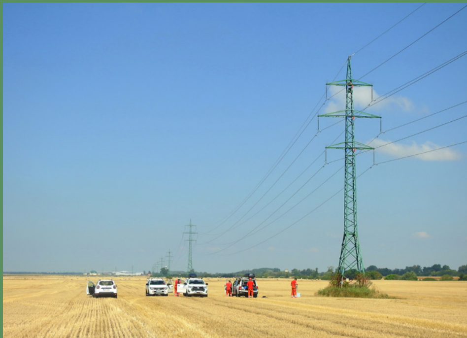
Obr. 1 Elektrické vedenie 110 kV vybrané na inštaláciu búdok.
