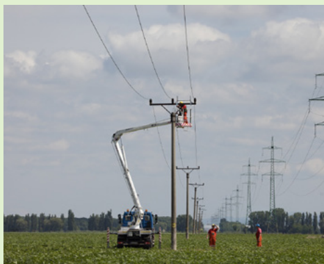
Obr. 3 Ošetrovanie konštrukcií 22 kV vedenia v priamej blízkosti hniezda obsadeného rárohmi.
