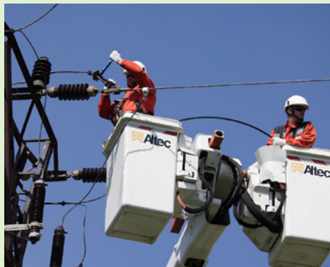
Obr. 1 Odstraňovanie nebezpečných preponiek na vrchu železného stĺpa.
