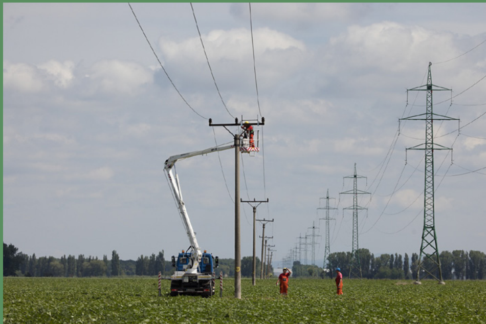
Obr. 4 Bezpečné stĺpy 22 kV, ktoré pribudli v hniezdných teritóriách sokola rároha.
