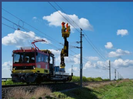
Obr. 2 Inštalácia chráničiek a odkloňovačov letu vtáctva na železničné vedenia v Rakúsku. (E.H.)
