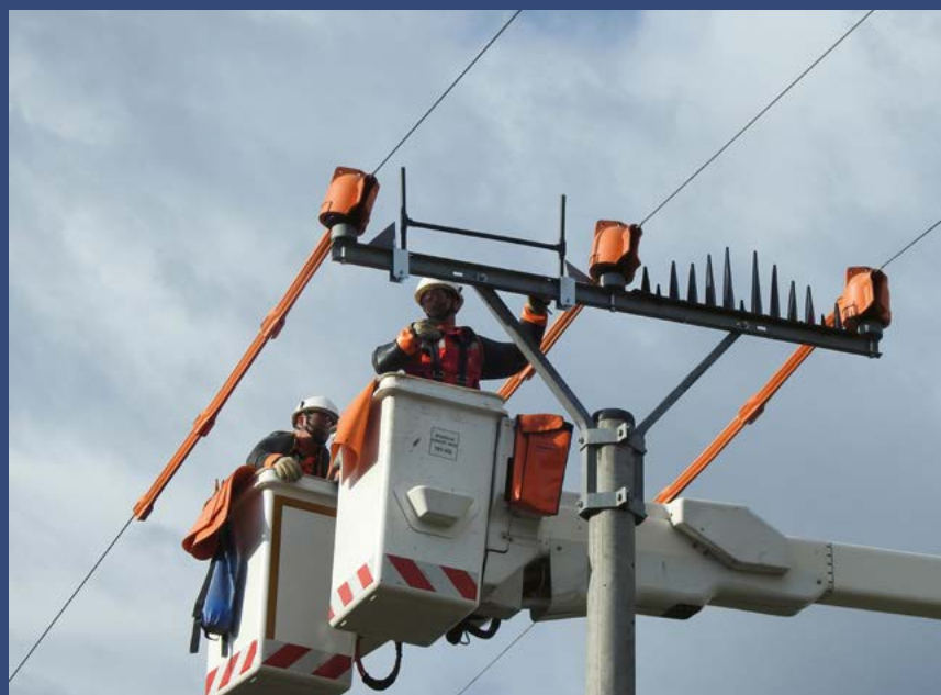
Obr. 6 Výmena starých zábran (vpravo) za nové chráničky, ktoré umožnia dravcom bezpečne využívať stĺpy 22 kV. (M. G.)
