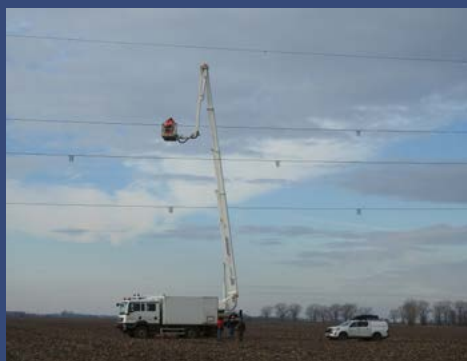
Obr. 8 Inštalácia odkloňovacích prvkov z plošiny. V prípade takýchto prác musí byť vedenie vypnuté. (M. G.)
