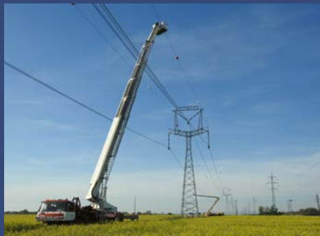
Obr. 4 Inštalácia odkloňovacích prvkov na prenosové vedenia 400 kV (vľavo), inštalácia bezpečných chráničiek na stĺpy 22 kV. (M.G.)
