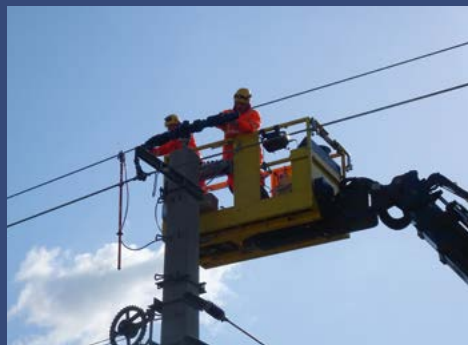
Obr. 2 Inštalácia chráničiek a odkloňovačov letu vtáctva na železničné vedenia v Rakúsku. (E.H.)
