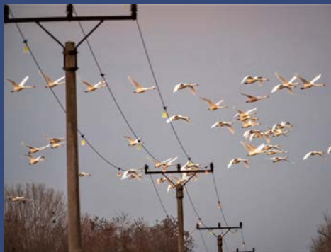
Obr. 6 Bezpečný prelet ponad ošetrené vedenie s odkloňovacími prvkami FireFly. (K. Š.)
