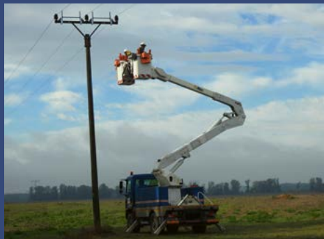
Obr. 4 Inštalácia odkloňovacích prvkov na prenosové vedenia 400 kV (vľavo), inštalácia bezpečných chráničiek na stĺpy 22 kV. (M.G.)
