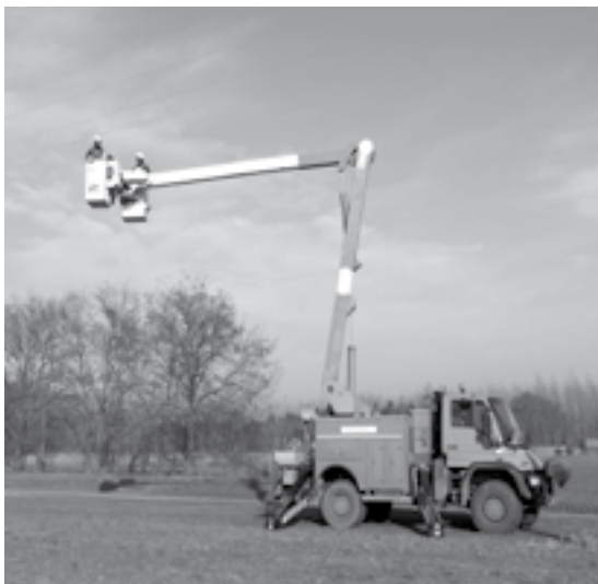
Inštalácia odkloňovačov na elektrické vedenie.
