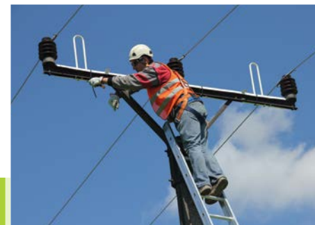
Osádzanie plastovej konzolovej chráničky na stĺp 22 kV elektrického vedenia. Foto: B. Maderič
