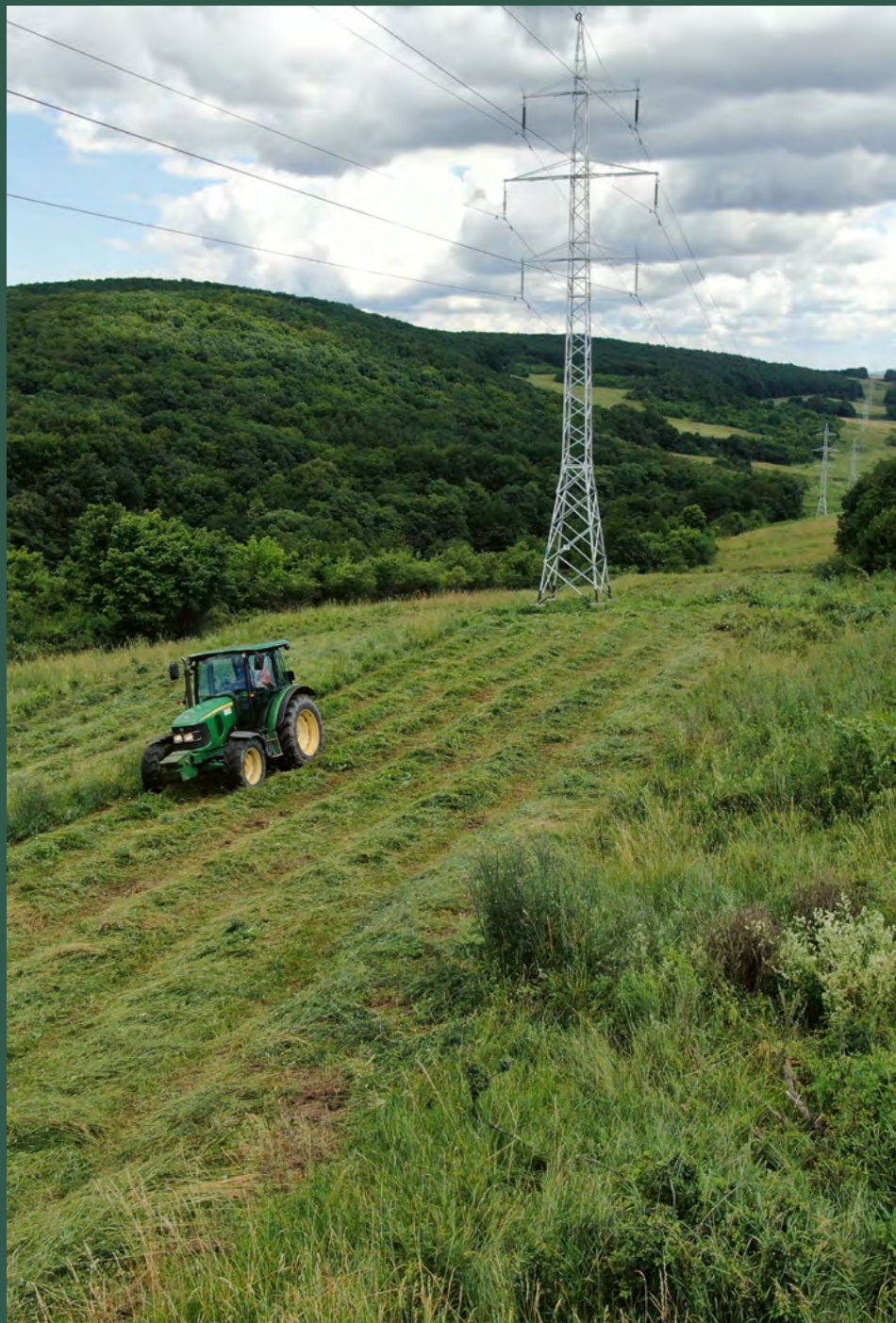
Kosenie stredového pásu v koridore elektrického vedenia.
